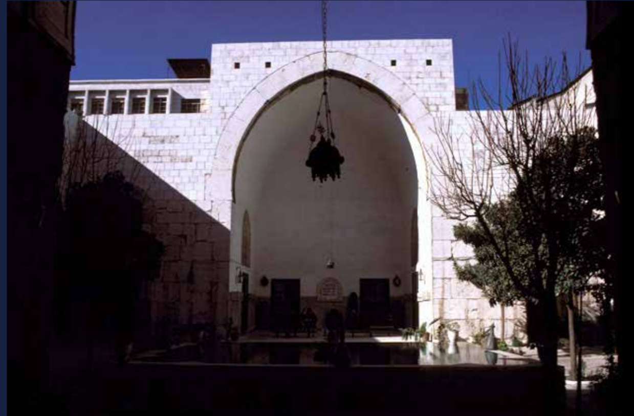
Figure 22 © Nasser Rabbat- bîmâristân Nur al-Din. Sur chacun des côtés de la cour s'inscrit un iwān au milieu des façades, pièce voûtée ne comprenant que 3 murs et souvent ouvert directement sur la cour.
