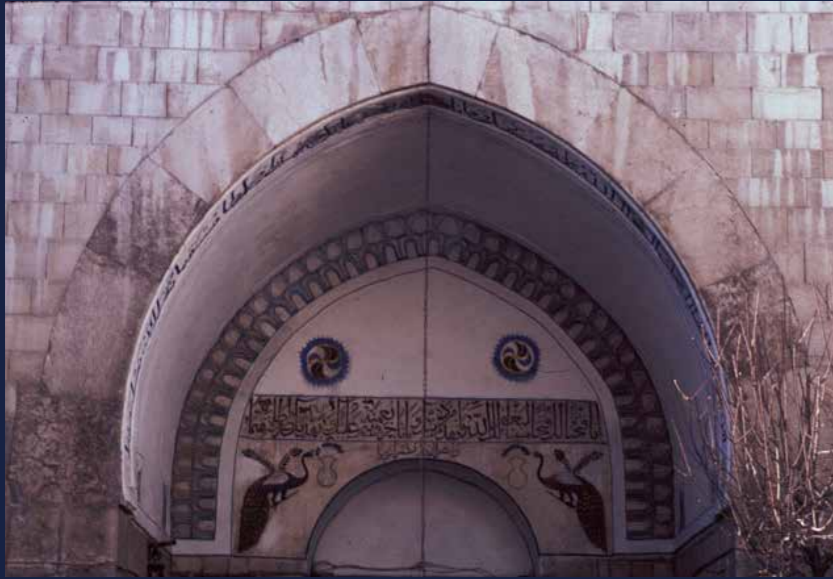
Figure 20 © Nasser Rabbat - bîmâristân Nur al-Din. Coupole à muqarnas typique du decor architectural musulman de Mésopotamie, formés d'alvéoles qui décorent le portail d'entrée taillé dans de la pierre.
